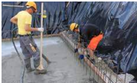
Bétonnage de la plaque de fond
