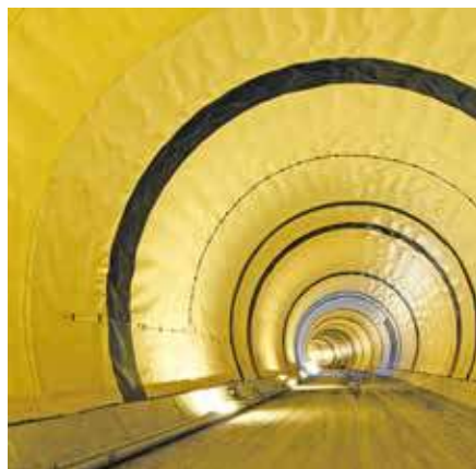
Étanchéité de tunnel
