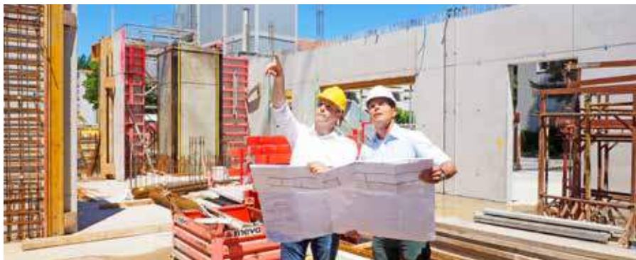
Contrôle sur le chantier
