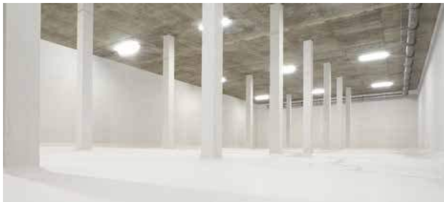
Revêtement à base de ciment pour réservoir
