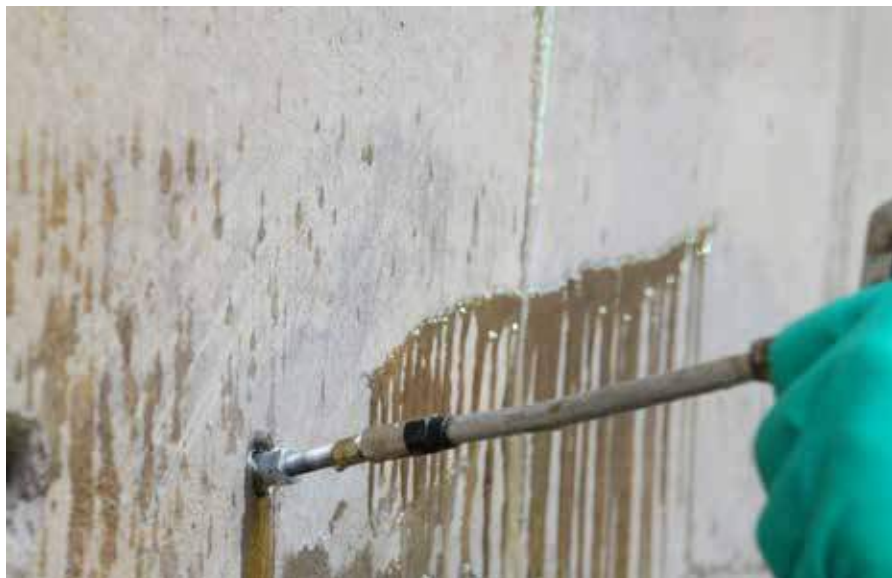
Injection dans une fissure aquifère d'une cuve blanche pour atteindre la classe d'étanchéité 1.
