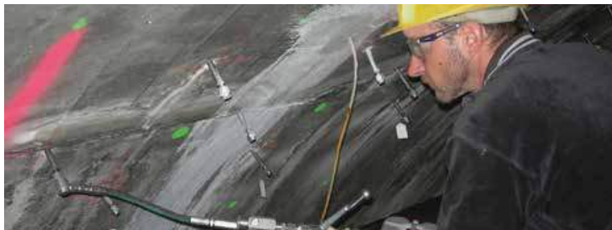
Scellement des fissures
