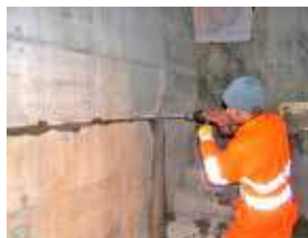
Perçage des fissures
