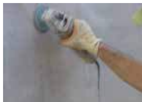
Élimination de la peau du béton
