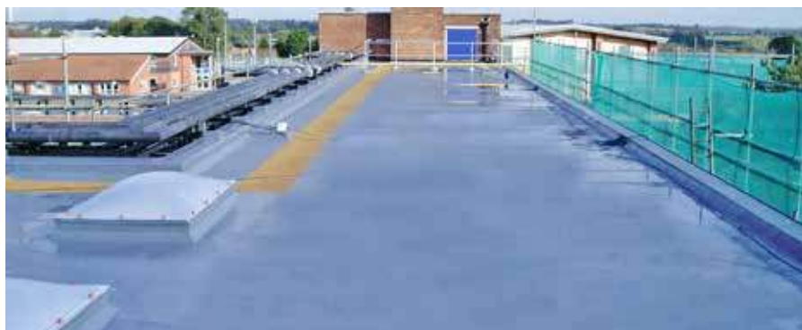
Toit plat étanchéifié
