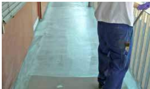
Application d'un revêtement pour balcon
