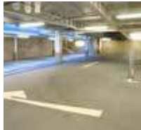
Parois de parkings souterrains
