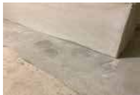
Reprofilage du revêtement de sol
