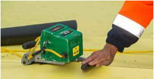
Soudage de membranes d'étanchéité en plastique
