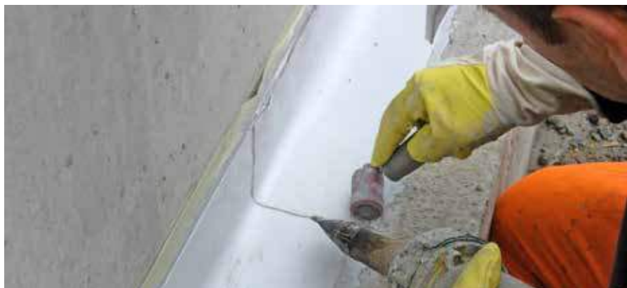
Soudage du système Sikadur-Combiflex® SG
