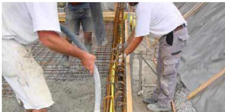
Pose de bandes d'étanchéité
