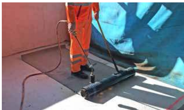
Flammage de membranes PBD
