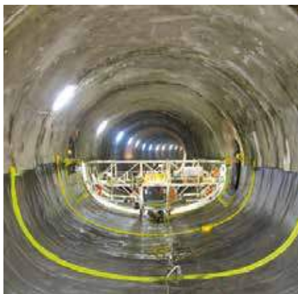
Zone de fond étanchées
