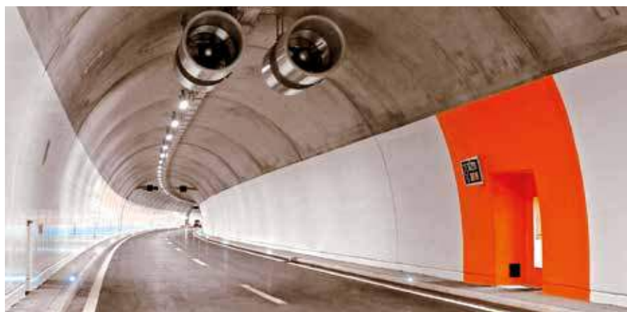
Tunnel routier terminé
